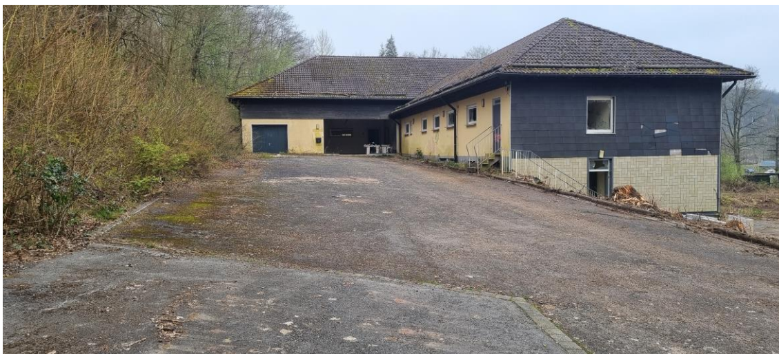
Foto 1: Bestandsgebäude mit Zufahrt im Geltungsbereich
